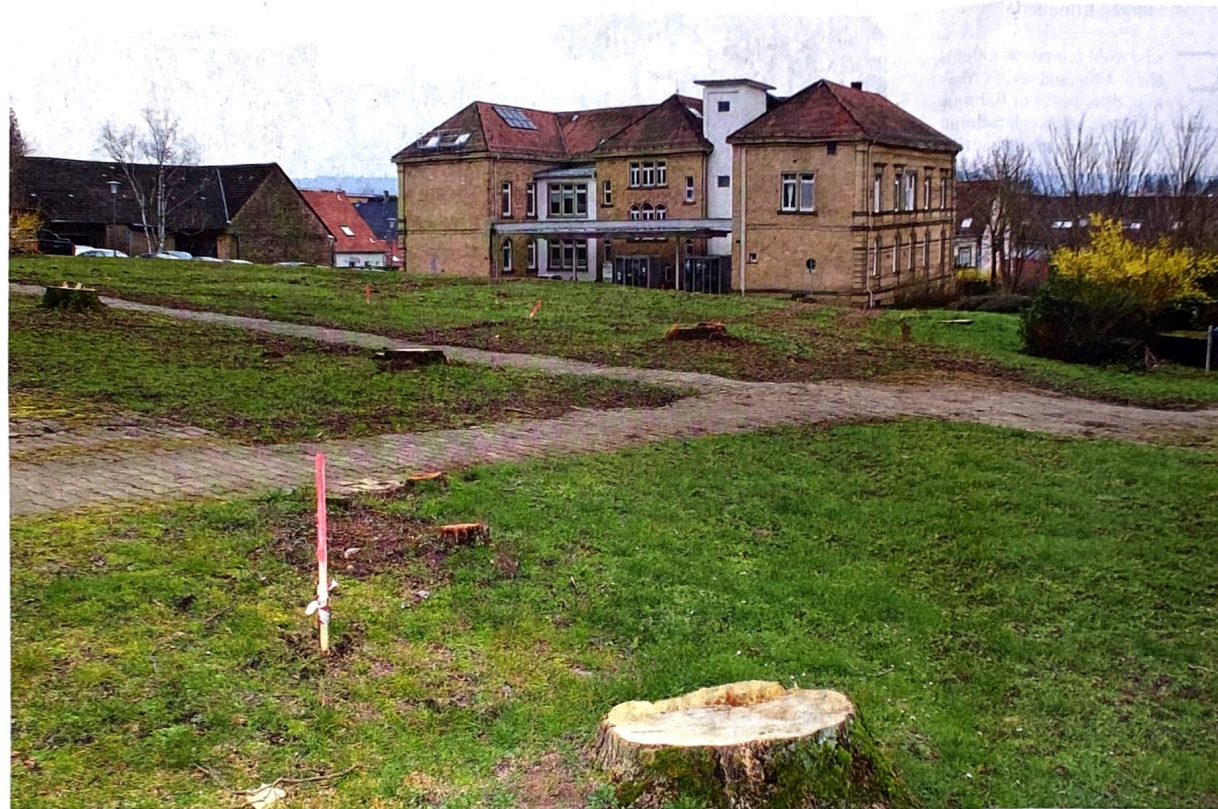
Die auf dem Gelände stehenden Bäume sind bereits gefällt. Die Lage des künftigen Baukörpers wurde mit Markierungsstangen abgesteckt.
